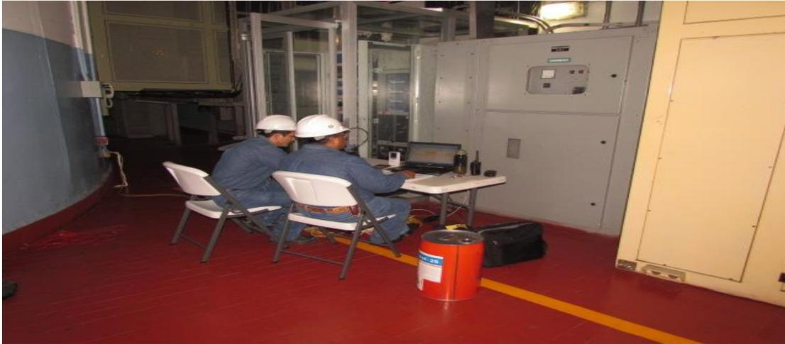
*Fig. A.14 Personal de CFE calibrando medidores de la U-6.*
