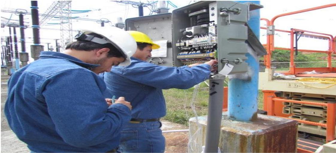
*Fig. A.13 Gabinete de control nuevo de cuchillas A1061.*
