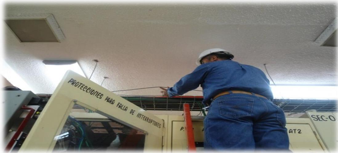
*Fig. A.9 Personal de cfe tendiendo cable de red para comunicación.*
