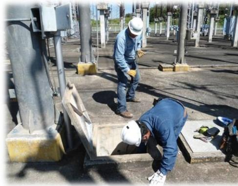
*Fig. A.4 Personal de CFE reubicando cables de control en campo.*
