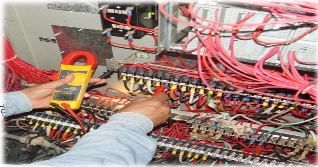
*Fig. A.8 Verificando puntos de mando para el control de interruptor.*
