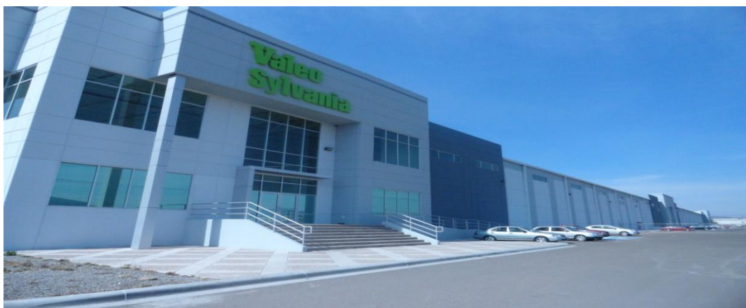
Figura 2.8 Fachada de Valeo Sylvania Planta 2 (Fuente: Elaboración Propia)
