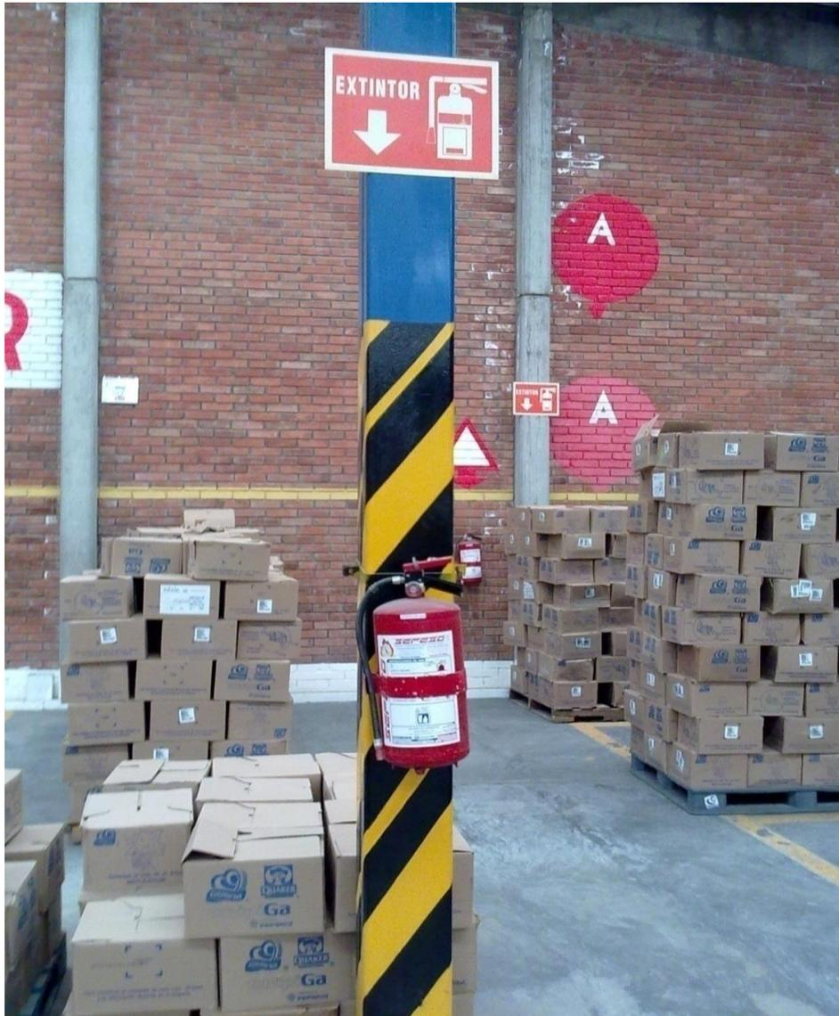
**Figura 5.8** Propuesta de utilización de las columnas para colocar señalamientos y extintores
