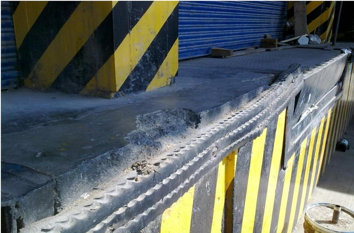
**Figura 4.21** Condiciones de maltrato en el área de plataformas y embarque
