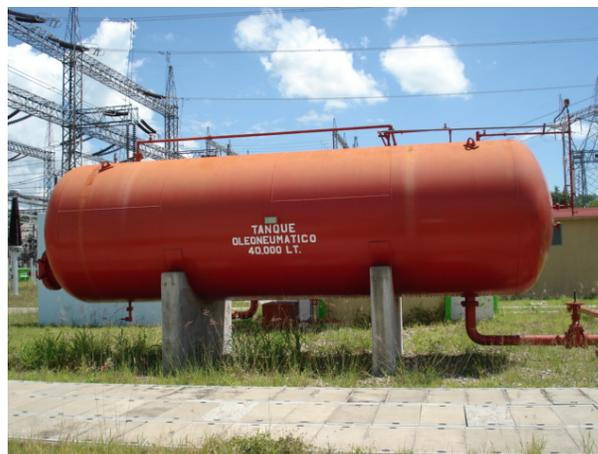
**Figura 4.2.2** Sistema Hidroneumático a Base de Diesel
