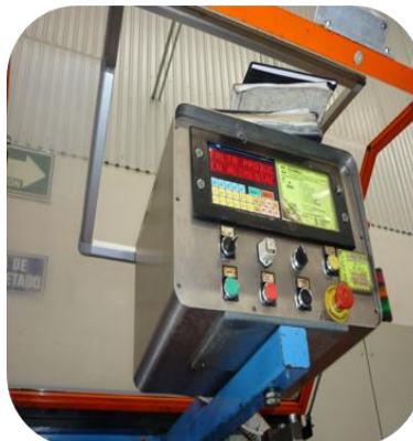
Figura 5.47 Objeto identificados en el módulo de control de la envolvedora Fuente: Fotos propias tomadas de la Empresa
