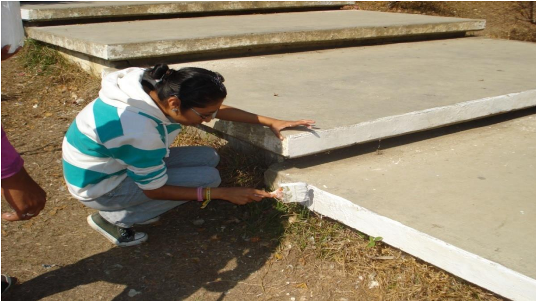
FOTO 33 Se pintaron los pasillo.
