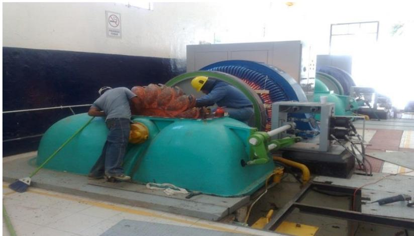
Figura No. 15. Limpieza del rodete de la turbina.
