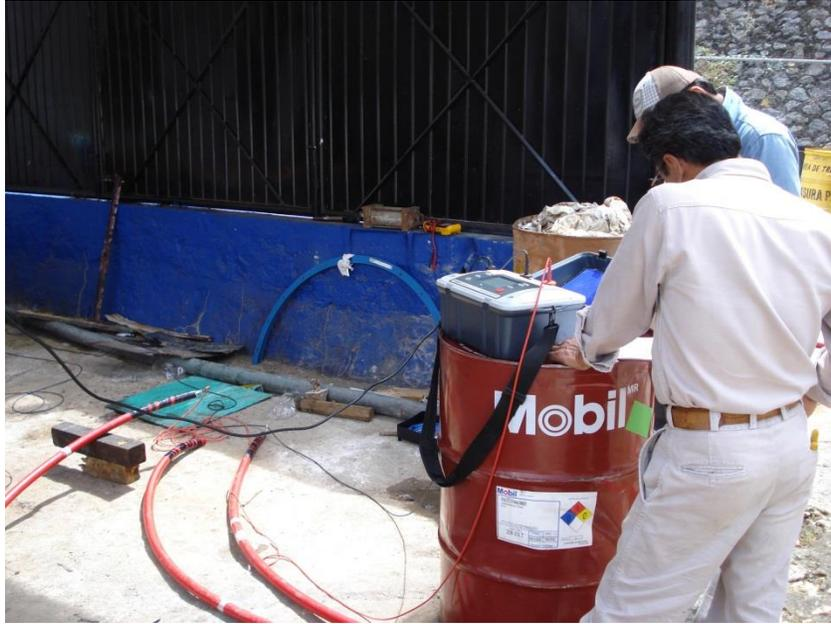
Figura No. 12. Cambios de cables de potencia de las unidades.
