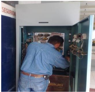
Mantenimiento de las instalaciones de pruebas al regulador de velocidad y cambio de cables de potencia.
