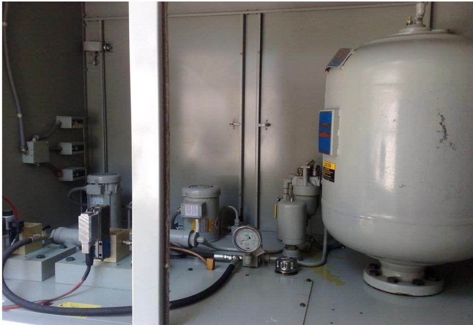
Figura No. 22. Depósito de presión en nitrógeno y aceite.
