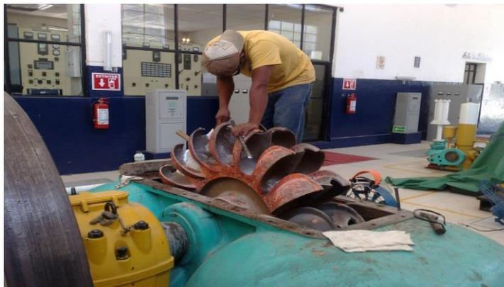
Figura No. 29. Mantenimiento de un rodete de turbina.
