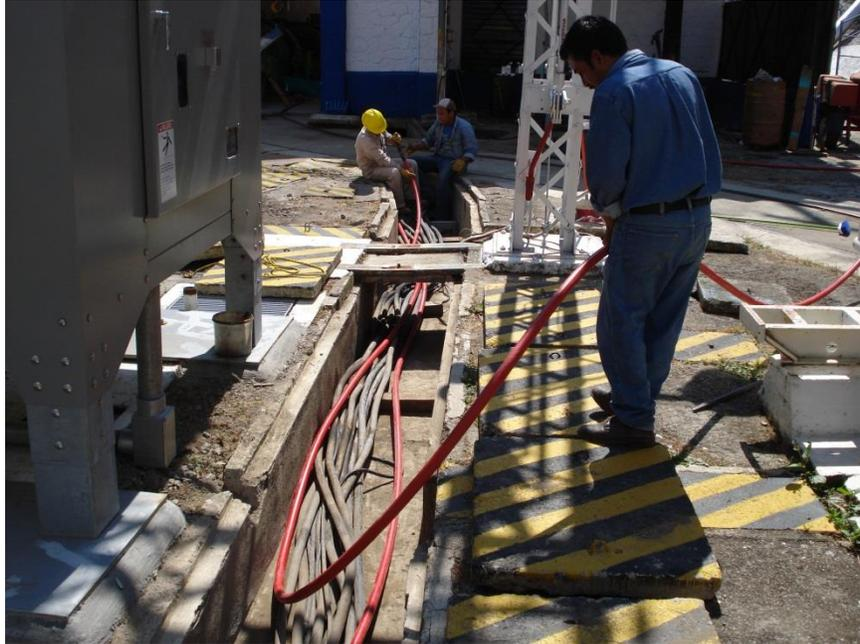
Figura No.9. Trincheras para cables de potencia.
