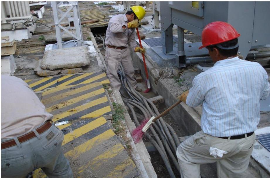
Figura No. 8. Trincheras para cables.
