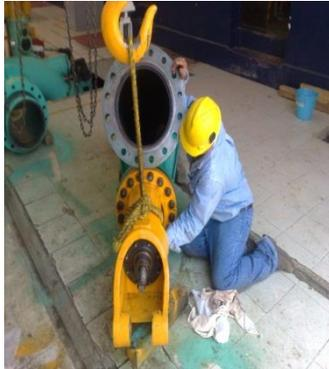
Desincrustaciones de pintura vieja, para aplicar pintura nueva y engrasar la aguja del generador para la válvula de esférica.
