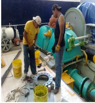
Limpieza y engraso de turbinas, válvula esférica de la maquina generadora.
