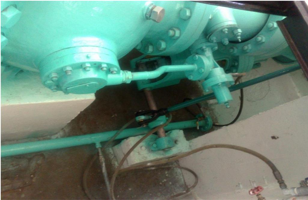
Figura No. 19. Tubería auxiliar para la apertura y cierre de la válvula esférica.
