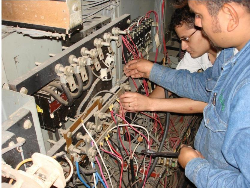
Figura No. 10. Alambrado de tableros de operación
