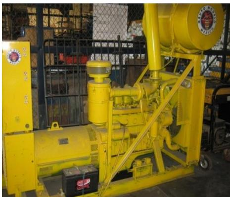
Figura 4-11. Planta generadora de energía
