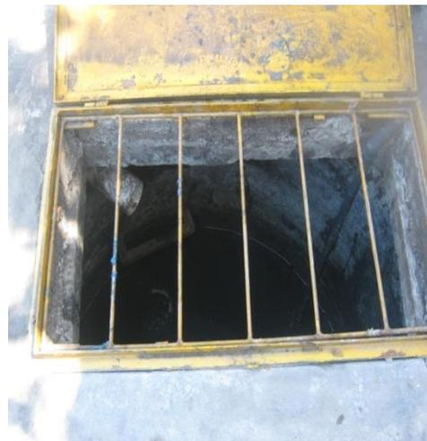
Figura 4-6. Alcantarilla de dren pluvial
