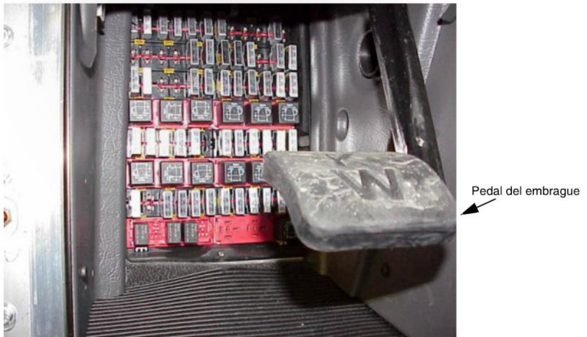
Figura 6.4 Caja de distribución de energía: Típica
