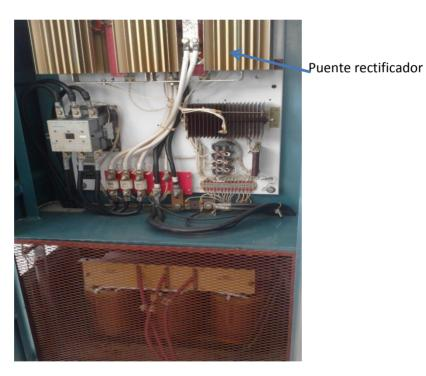
Figura 3.12 Tablilla del puente rectificador
