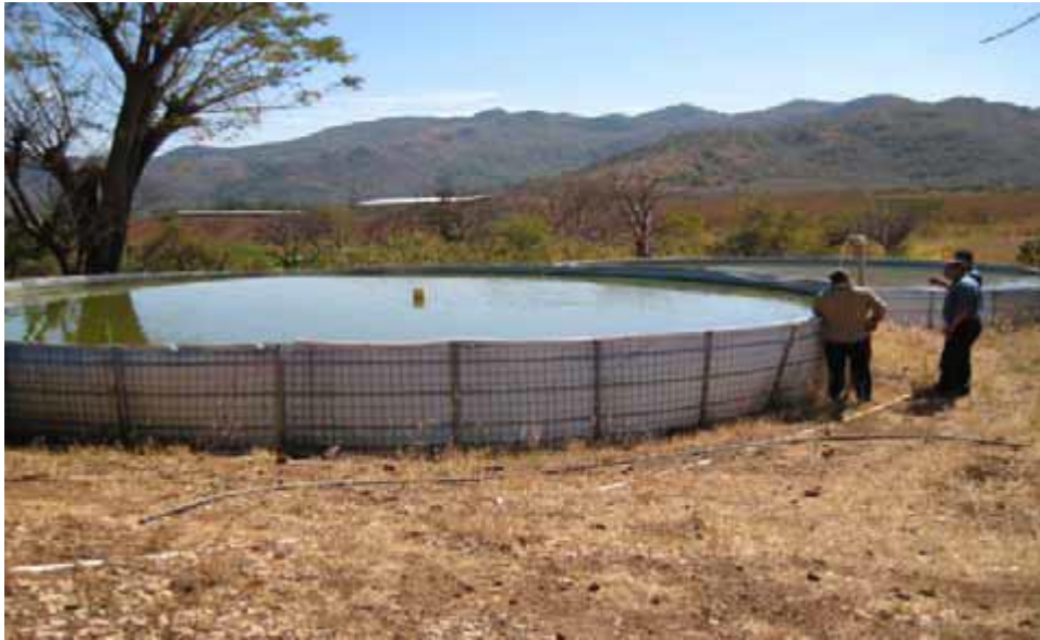
Figura 4.3 Modelo de estanque circular de geomembrana
