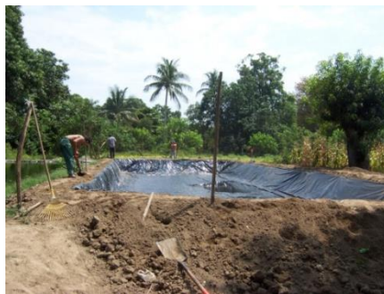
Figura 5.14 Colocación del plástico
