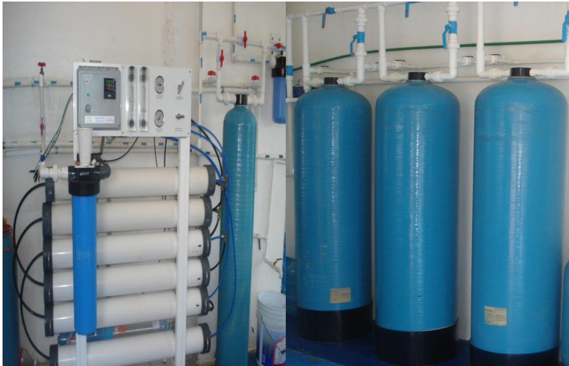
Foto 2-3 Área de filtros
