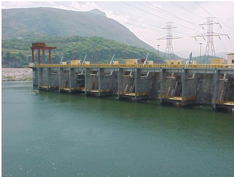
Figura 2.6 Obra de toma
