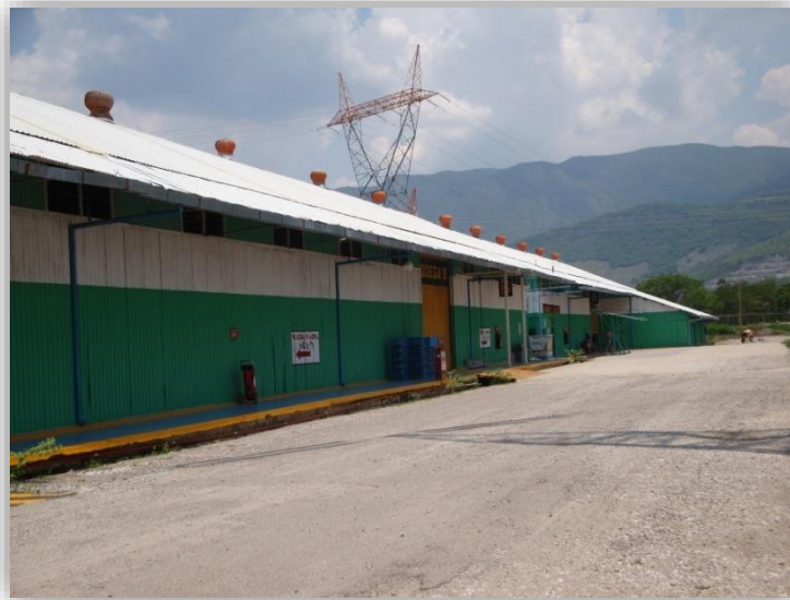
Figura 6.25 Salida de Emergencia Almacenes
