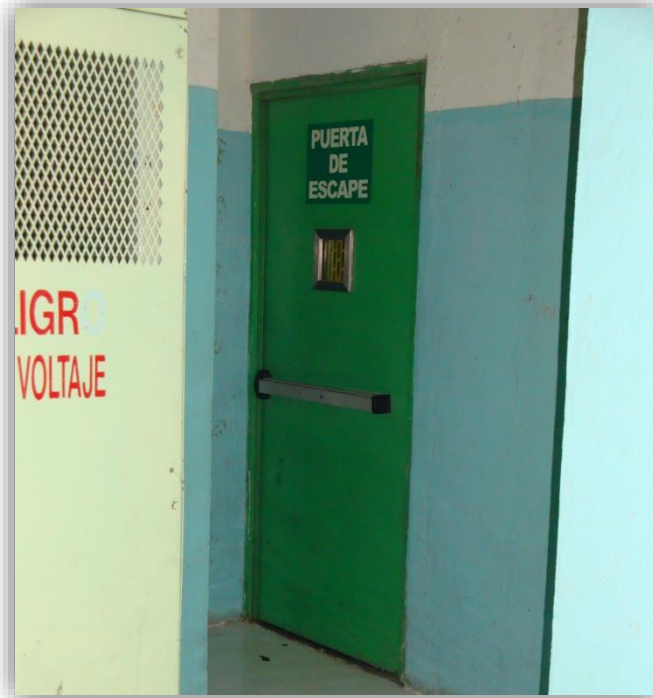
Figura 6.29 Salida de Emergencia Puerta de escape piso de turbinas
