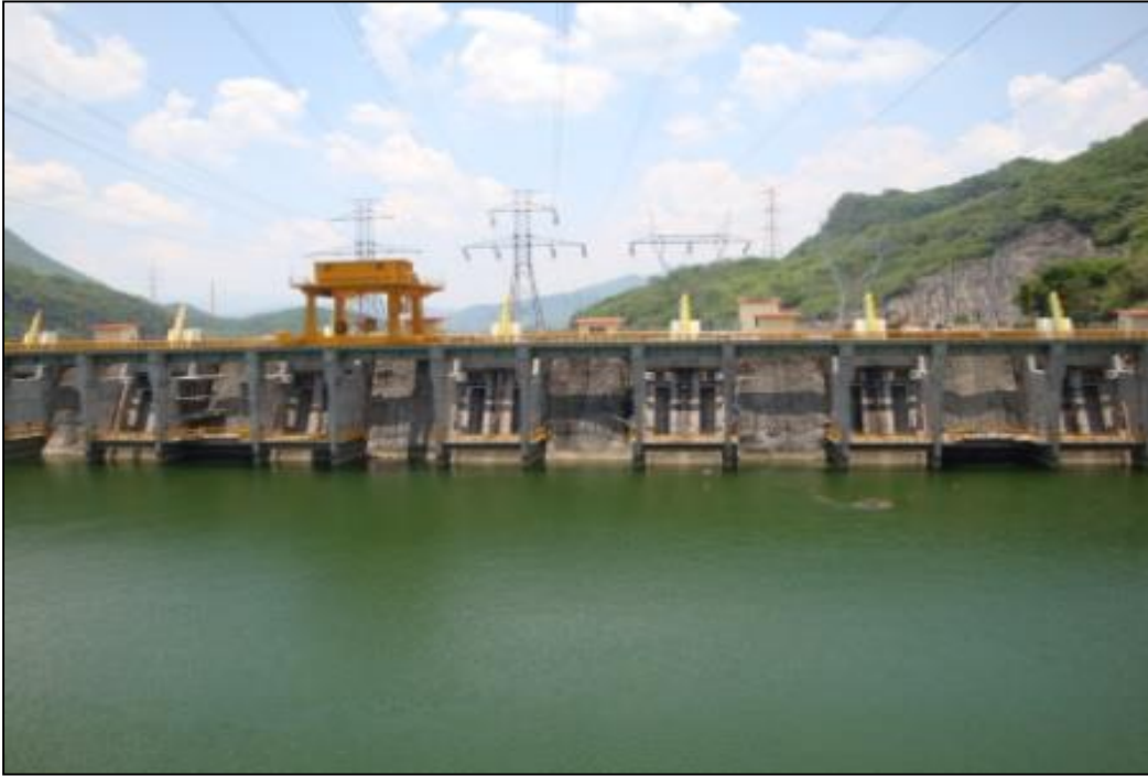
Figura 6.8 Obra de toma
