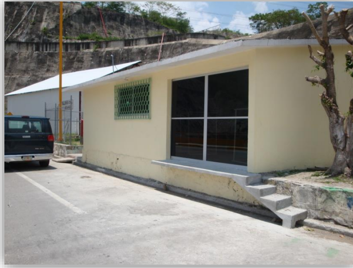
Figura 6.24 Salida de Emergencia Depto. Buzos y Taller Mecánico
