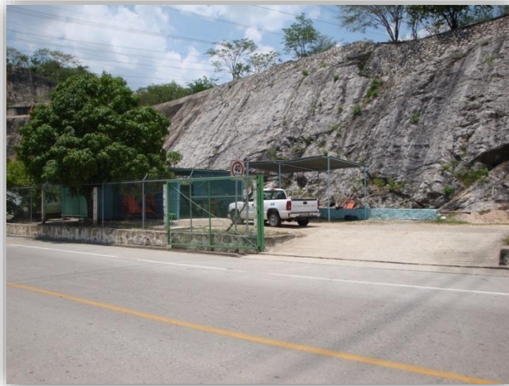
Figura 6.23 Salida de Emergencia Taller Civil
