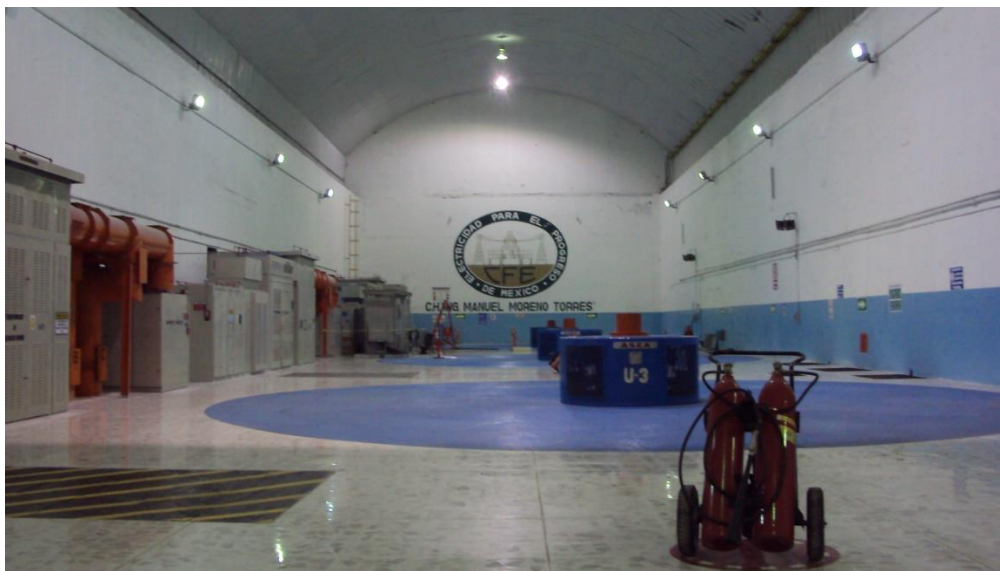
Figura 2.7 Casa de Maquinas
