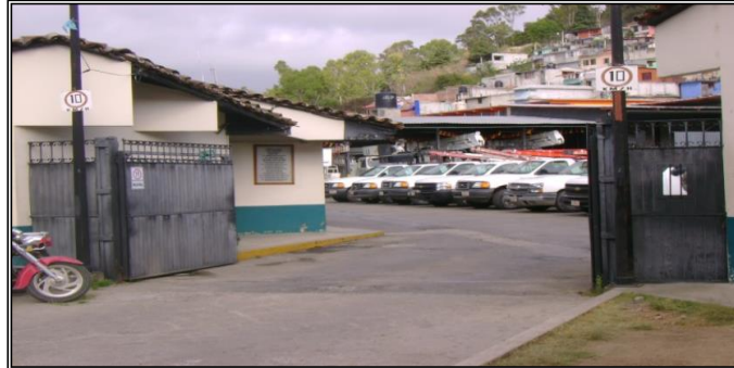
Imagen 4.1.1 Portón inadecuado de vigilancia.
