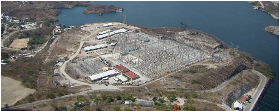
Figura 1.1 Vista aérea de la subestación Chicoasén
