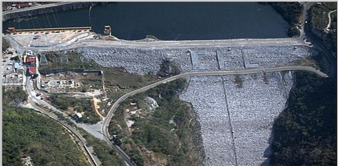
Figura1.2 Vista aérea de la Central Hidroeléctrica Manuel Moreno Torres.
