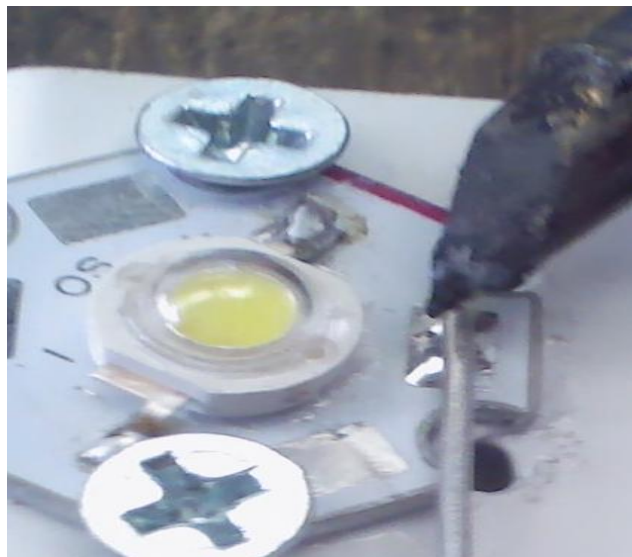
Figura 5.14 Punto de Soldadura (Fuente: Elaboración Propia)
