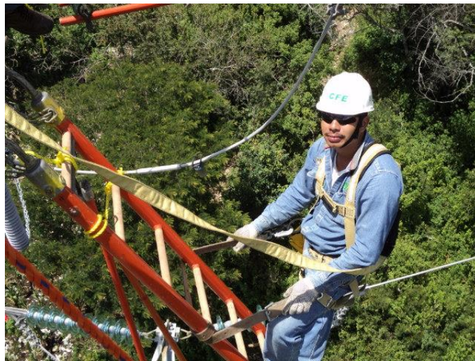
Fotografía N° 35 Linero con su Soga de Seguridad
