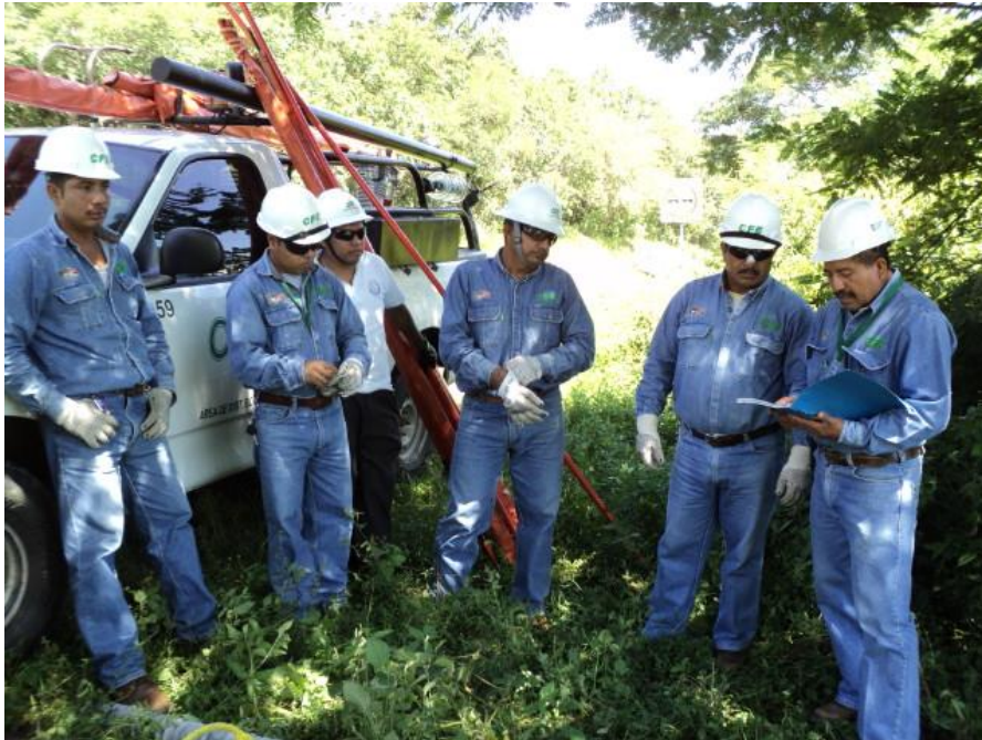
Fotografía N° 26 Planeación de la Maniobra
