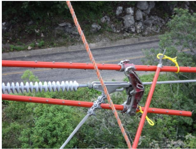
Fotografía N° 40 Yugo de Punto Caliente
