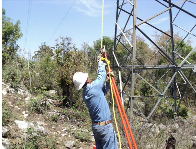
Fotografía N° 38 Subir Pértigas universales
