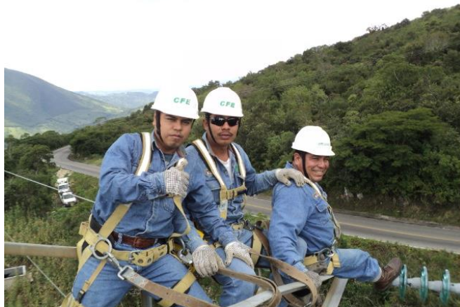
Fotografía N° 31 Liniero en la punta de la cruceta
