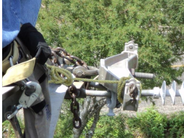
Fotografía N° 34 Yugo de Tensión de Punto Frio
