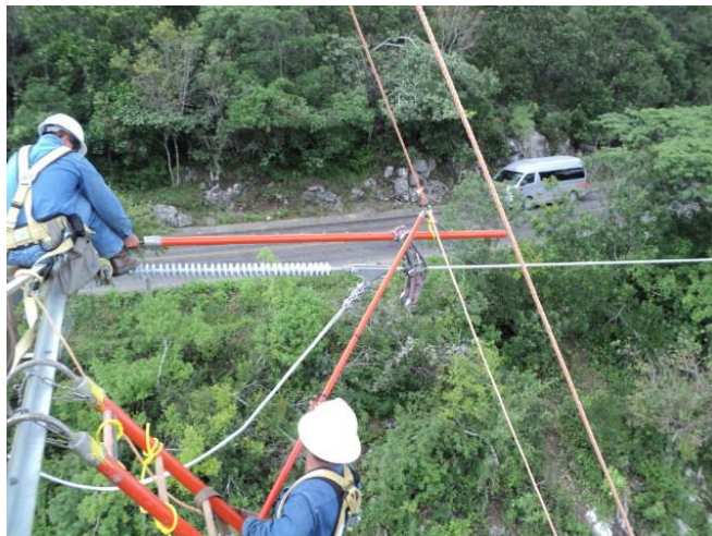
Fotografía N° 39 Instalación de Pértiga de tensión
