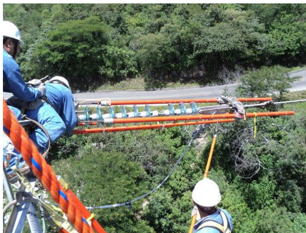
Fotografía N° 41 Instalan Tensor
