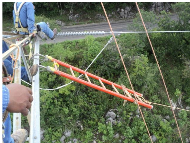
Fotografía N° 33 Instalación de Escalera
