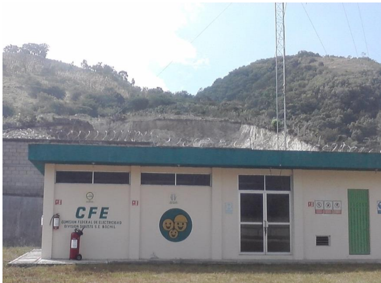
Fotografía N° 19 Cuarto de Baterías
