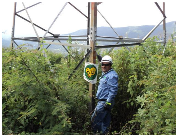
Fotografía N° 27 Instalación de la Manta Móvil
