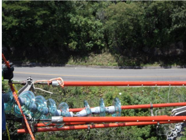
Fotografía N° 44 Tensionar las Tuercas muñón
