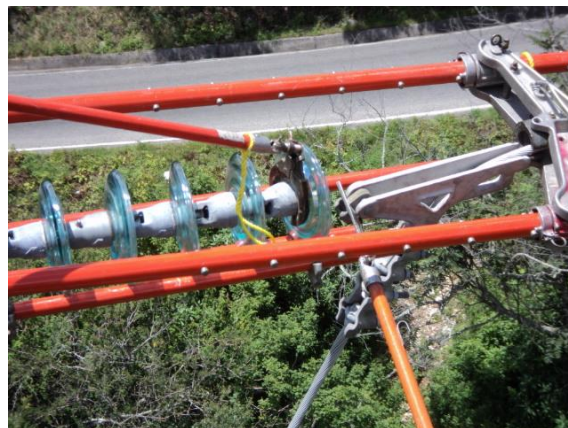
Fotografía N° 43 Remover la Chaveta
