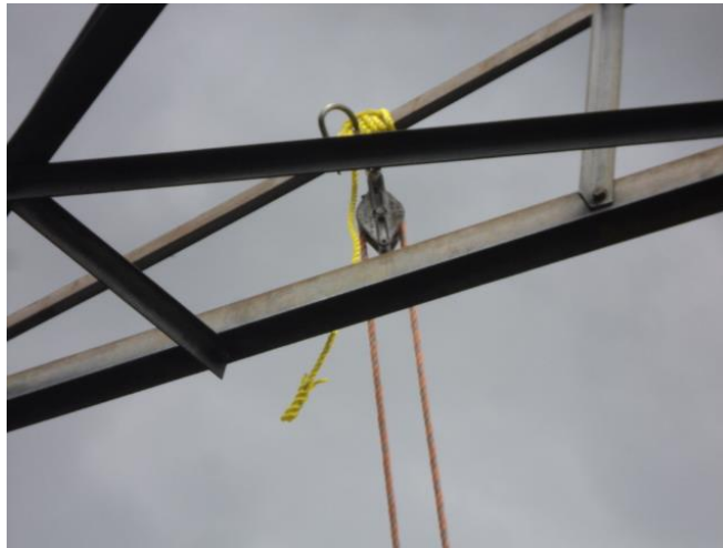
Fotografía N° 30 Posición Correcta de la Soga Mandadera
