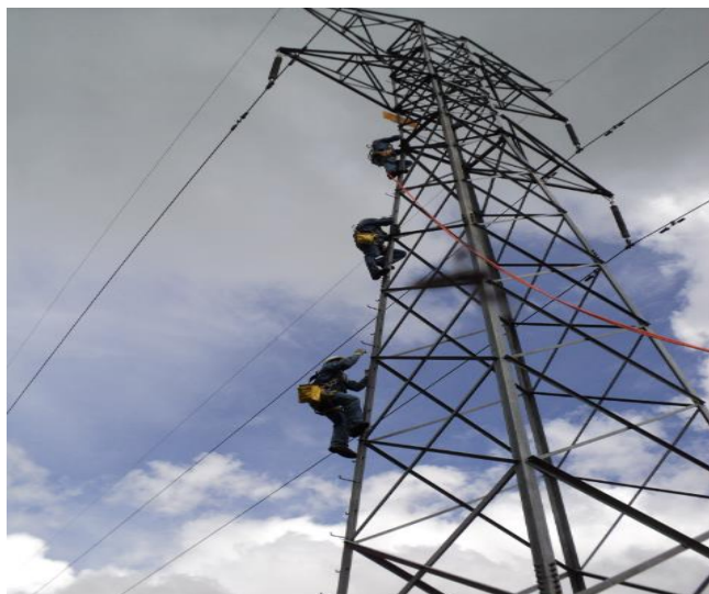
Fotografía N° 29 Linieros Ascendiendo a la Estructura
