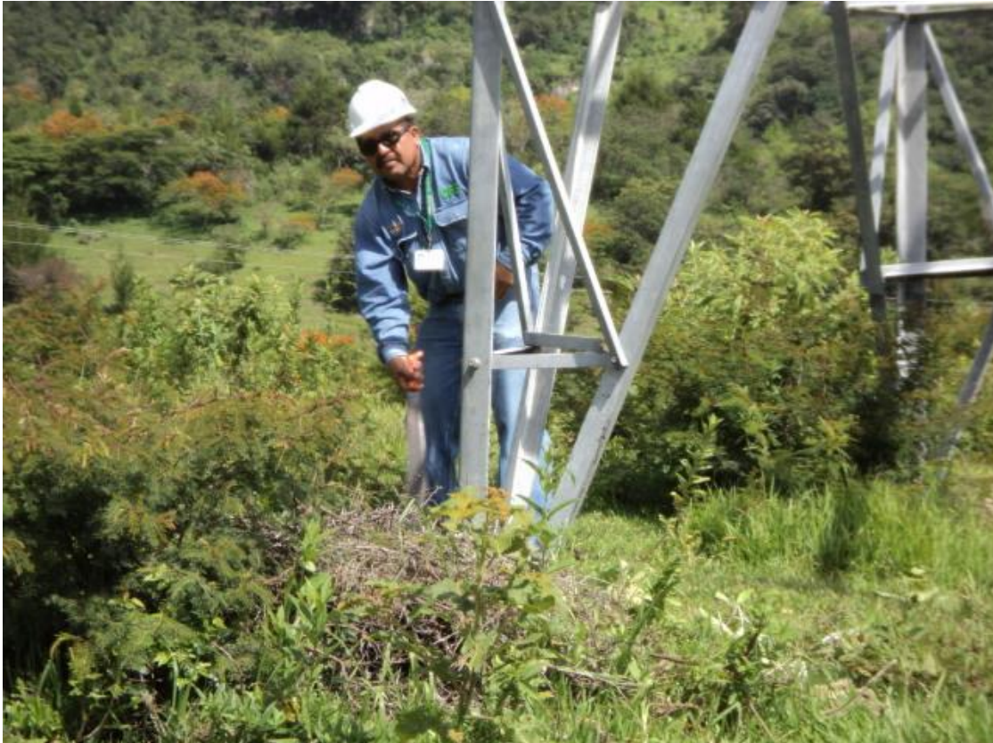
Fotografía Nº 23 Inspección Visual del Estado Físico de la Estructura
