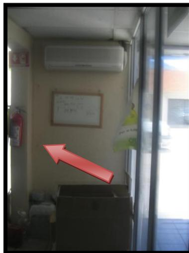
**Figura 5.12** Extintor mal colocado.
