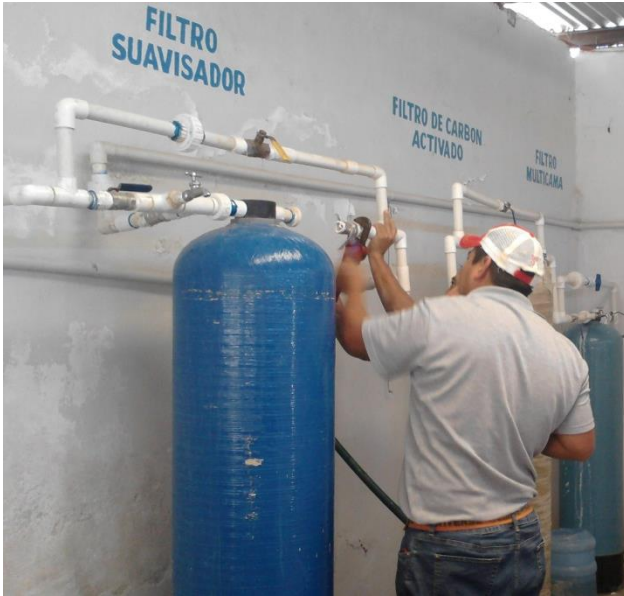
Figura 5.6 Participación de los operarios para realizar mantenimiento preventivo.
