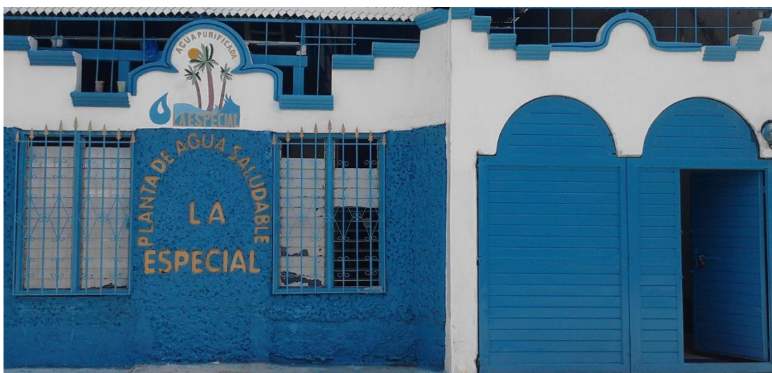
Figura 2.2 Imagen de la planta de agua saludable La Especial.
