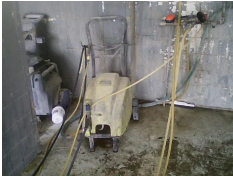
Imagen 5.11. Condición inicial del área de lavado
