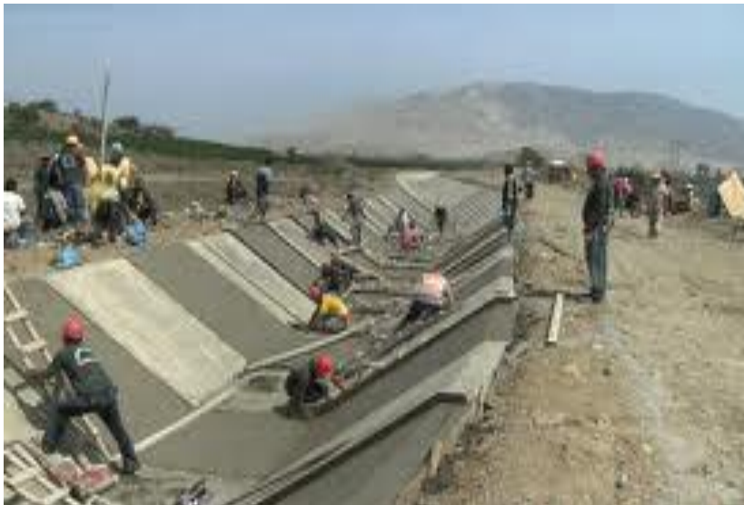
Imagen 4.2.2 Construcción de un canal de riego.
