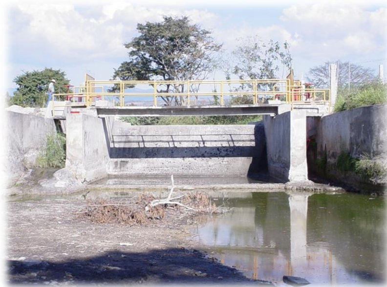
Imagen 4A. Canal Lateral 8+837 (recientemente rehabilitado).
