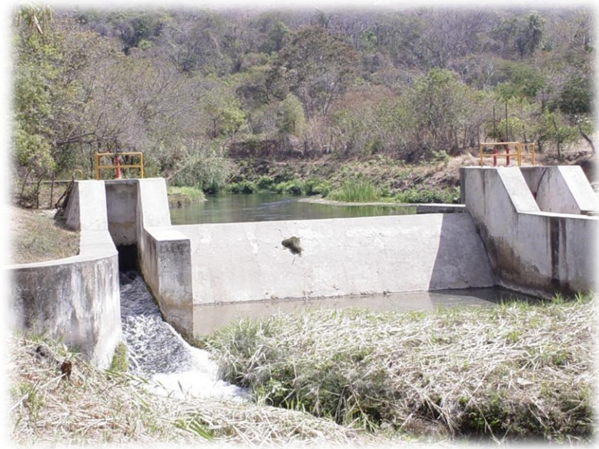
Imagen 3A. Trabajos de rehabilitación y revestimiento realizados en el año 2012.
