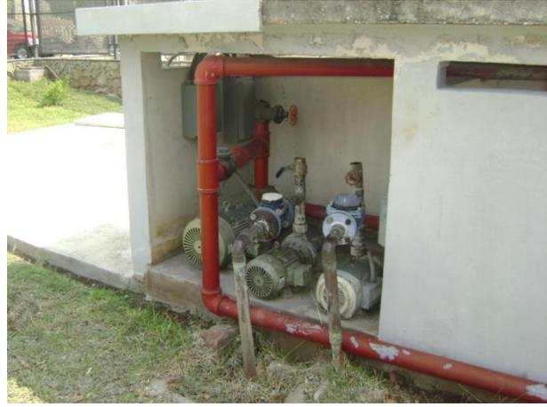
Tubería del Hidrante color deteriorado de Edificio Anexo Administrativo.
