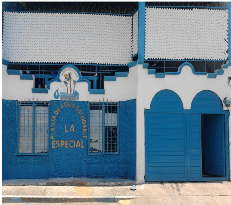
Figura 6.2 Fachada de la empresa actual
