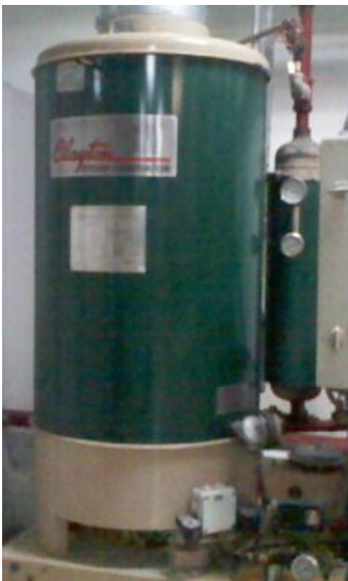
Figura 4.2. Generador acuotubular, marca Clayton.
