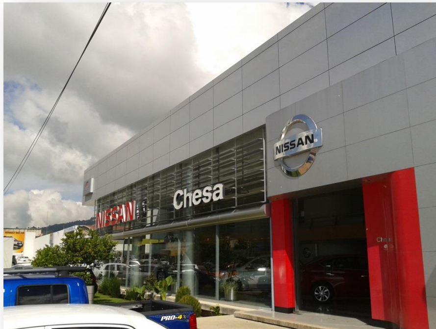
Figura 5.17 Mantenimiento y Limpieza en la fachada de la empresa
