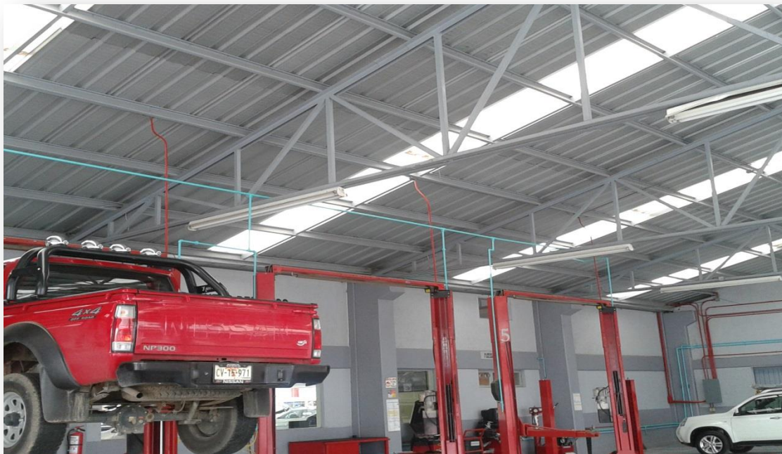
Figura 5.3 Pintado de tuberías de aire en el área de Postventa
