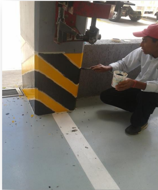
Figura 5.14 Pintado de columnas de seguridad
