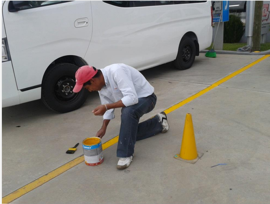
Figura 5.16 Pintado de líneas en el estacionamiento
