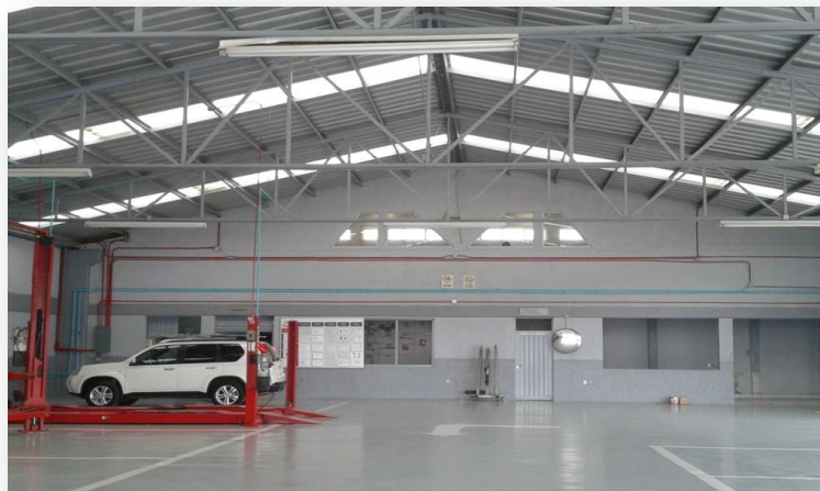
Figura 4.2 Inspección en el Área de Postventa
