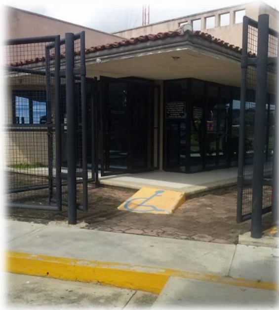
Figura 2-5. Rampa para el acceso de personas discapacitadas
