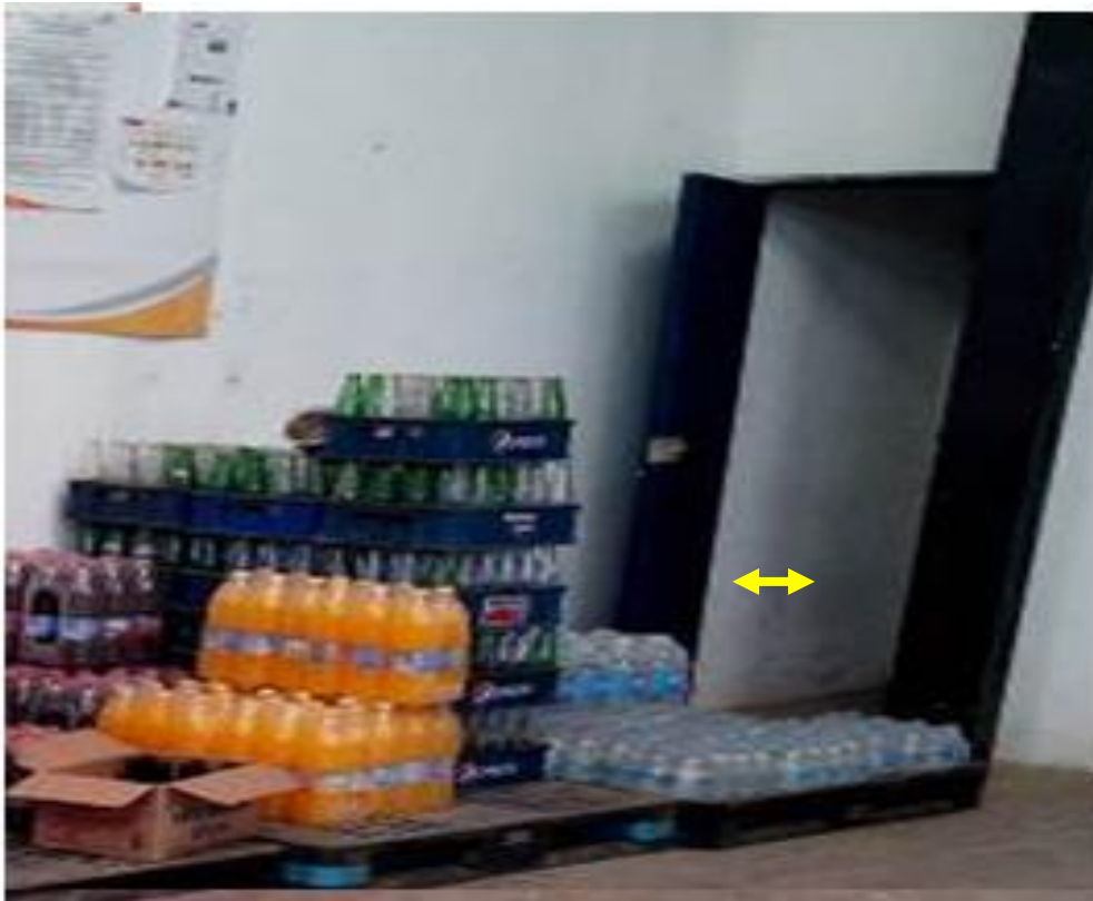
Figura 4.4 Obstrucción de puerta
