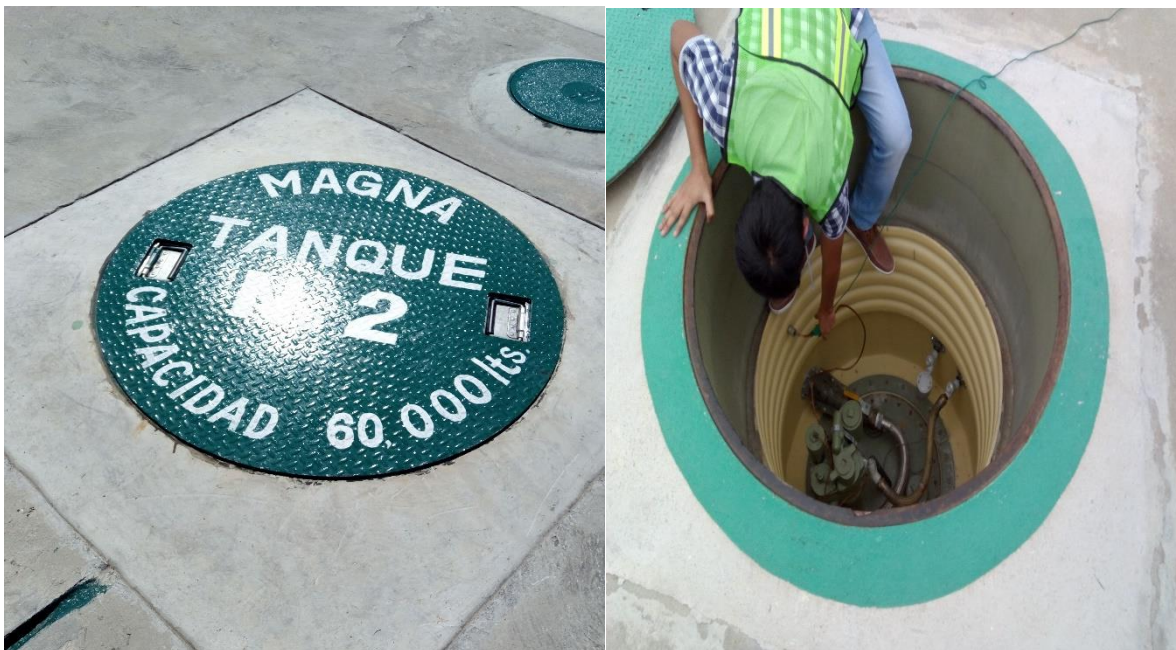
Fig. 3.4 Inspección del tanque de Magna
