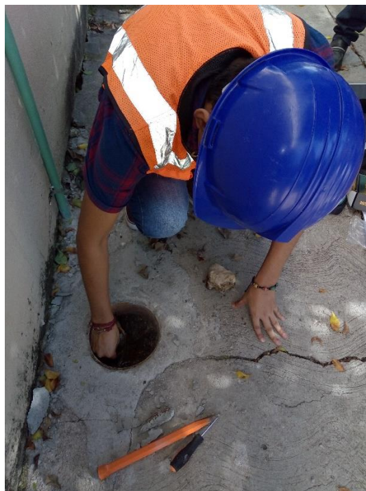
Fig. 3.17 Medición de acometida principal
