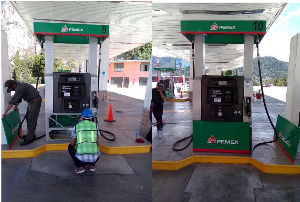
Fig. 3.24 Medición del dispensario 9-10
