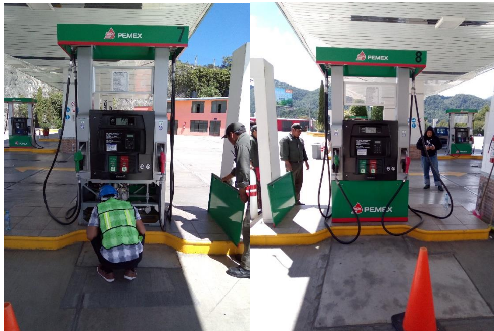
Fig. 3.23 Medición del dispensario 7-8
