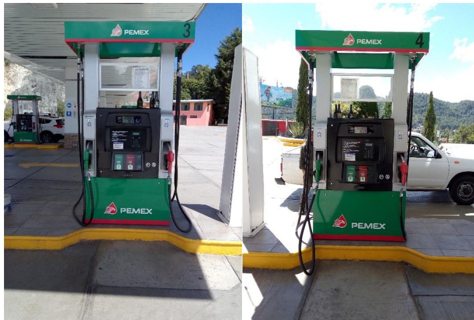
Fig. 3.21 Medición del dispensario 3-4
