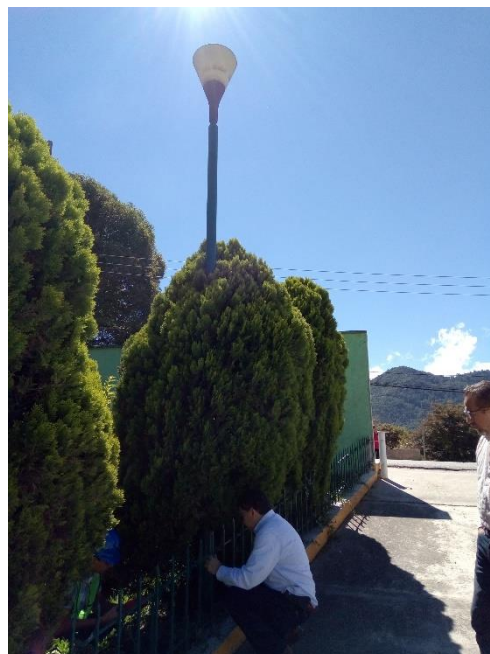
Fig. 3.9 Medición de lámpara entrada de gasolinera
