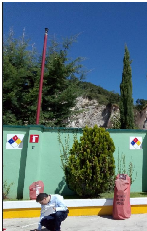
Fig. 3.15 Medición del tubo de venteo tanque Premium
