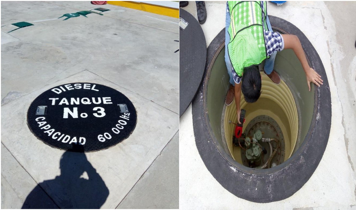
Fig. 3.5 Inspección del tanque de Diesel
