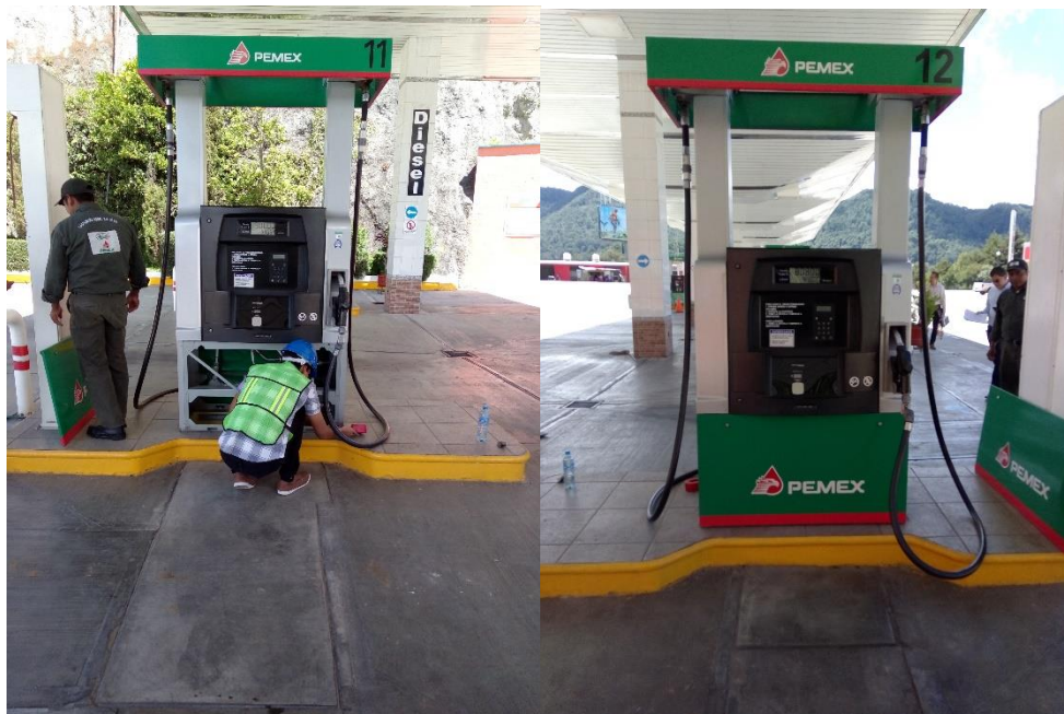
Fig. 3.25 Medición del dispensario 11-12
