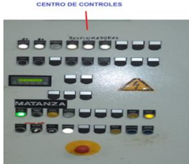
IMAGEN 5.4.1 CONTROLES DESPLUMADOR Y MATANZA.
