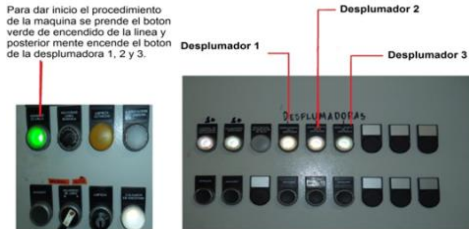
IMAGEN 5.4.2 CONTROLES DESPLUMADOR.
