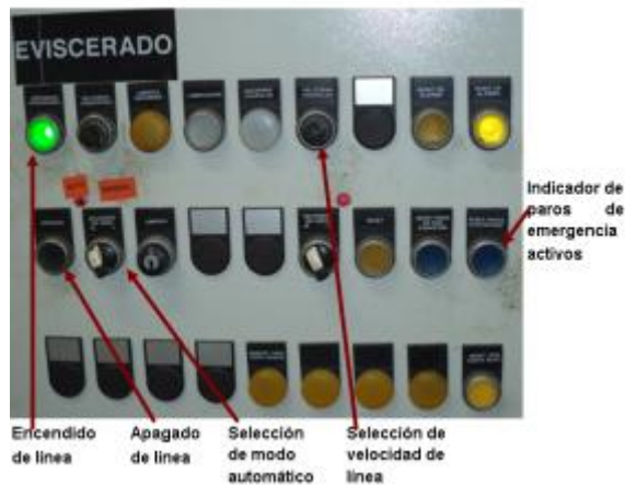
IMAGEN 5.10.6 ENCENDIDO DEL CCM.
