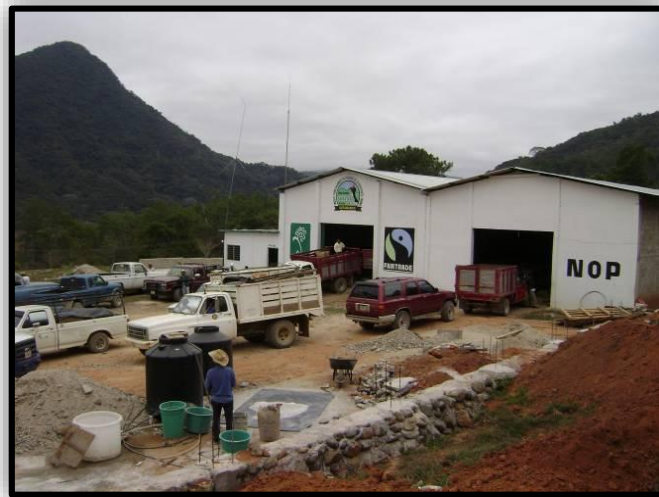
Imagen 2.1. Construcción de la bodega URSC 2003
