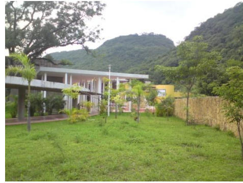
Figura 6- Ubicación De Los Aerogeneradores
