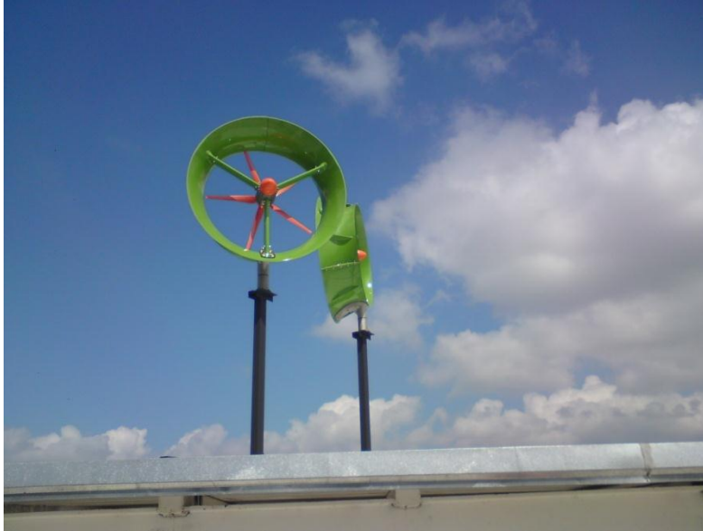
Figura 3- Montaje de los aerogeneradores JPS-200
