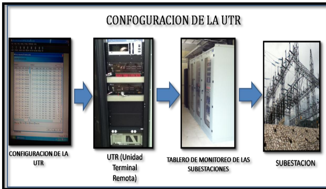
Figura 6.13 Proceso de la configuración de la UTR
