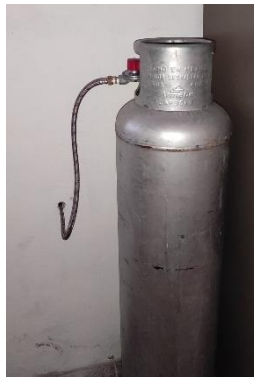
Ilustración 8. tanque de suministro de gas
