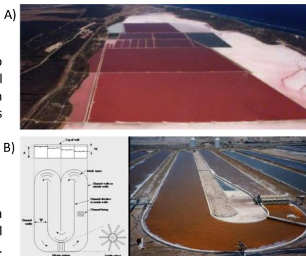
**Figura. 6.-** Tipos de fotobiorreactores abiertos. A) Open ponds. B) Raceways
