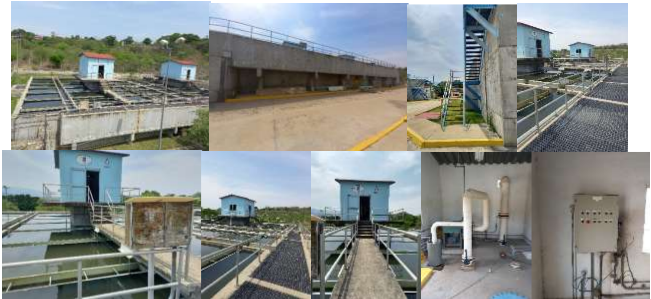
d) Área de filtros.
