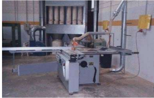
Figura 13.5. Sierra circular provista de extracción localizada y empujador de piezas.
