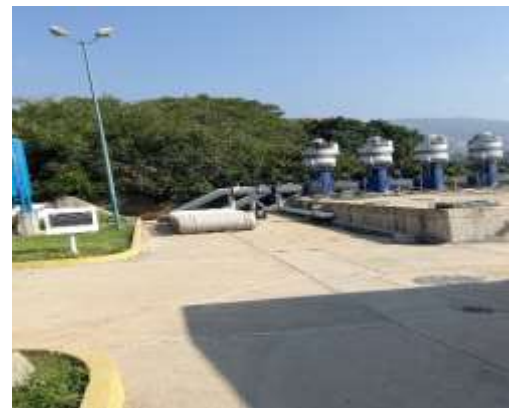
D) Cárcamo de bombeo.
