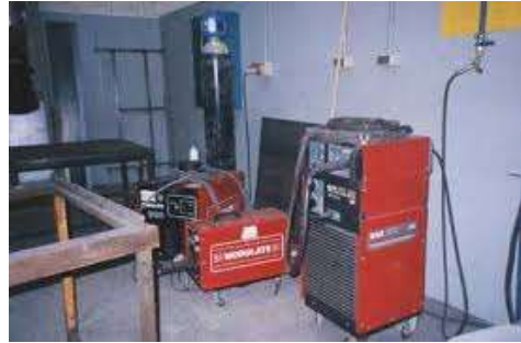
Figura 13.7. Grupos de soldadura eléctrica por arco tipo MIG.
