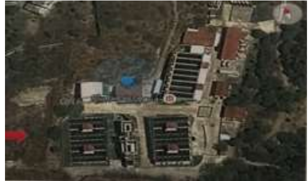
Cuarto incendio registrado en los alrededores de la planta potabilizadora (14 de abril de 2011 a las 10:00 horas).
