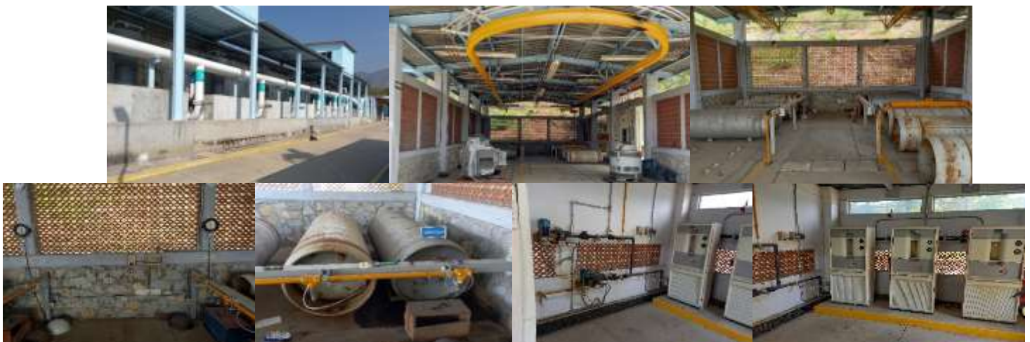
e) Área de cloración y almacén de gas cloro.
