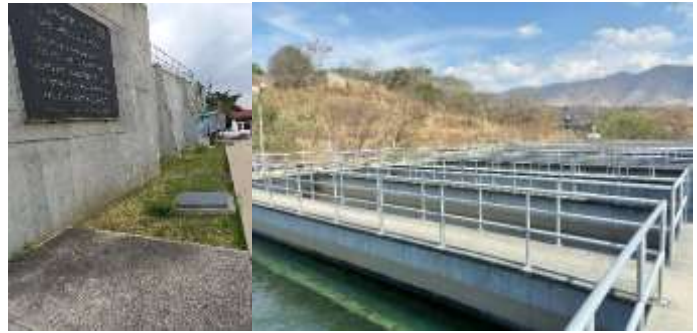
H) Área de filtros.
