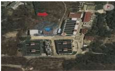
Figura 8.2. registros de incendios registrados.
