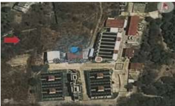
Quinto incendio registrado en los alrededores de la planta potabilizadora (18 de abril de 2012 a las 12:00 horas).
