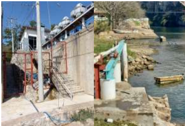
C) Obra de toma (PB0).
