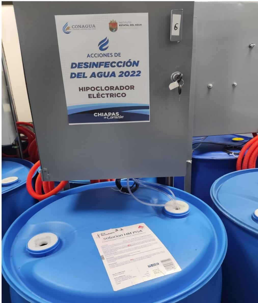
Ilustración 3 Hipo clorador eléctrico
