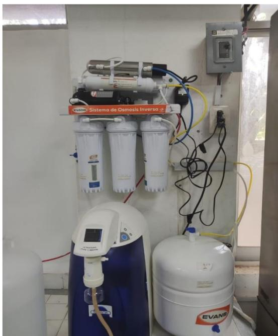
Imagen 6 Sistema de osmosis inversa para obtener agua destilada
