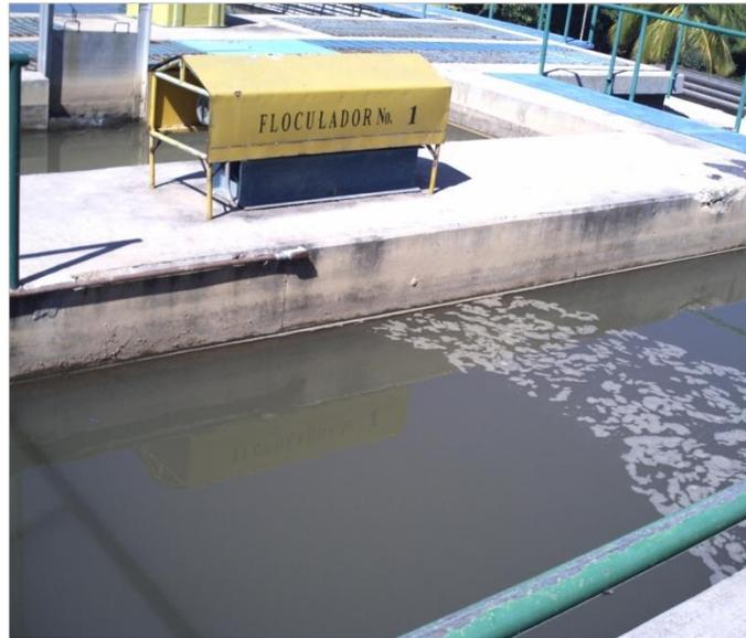
Figura 9. Fotografía del tanque de floculación con su respectivo agitador.
