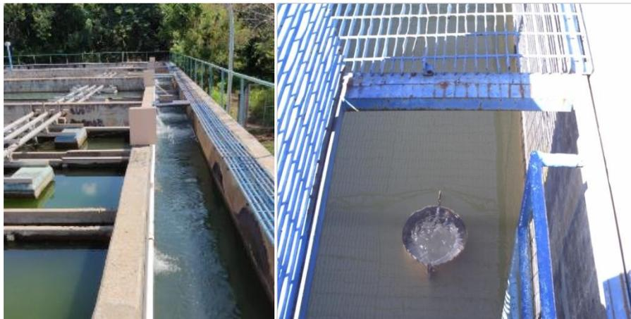
Figura 12. Fotografía del canal colector y del sistema de collarines.
