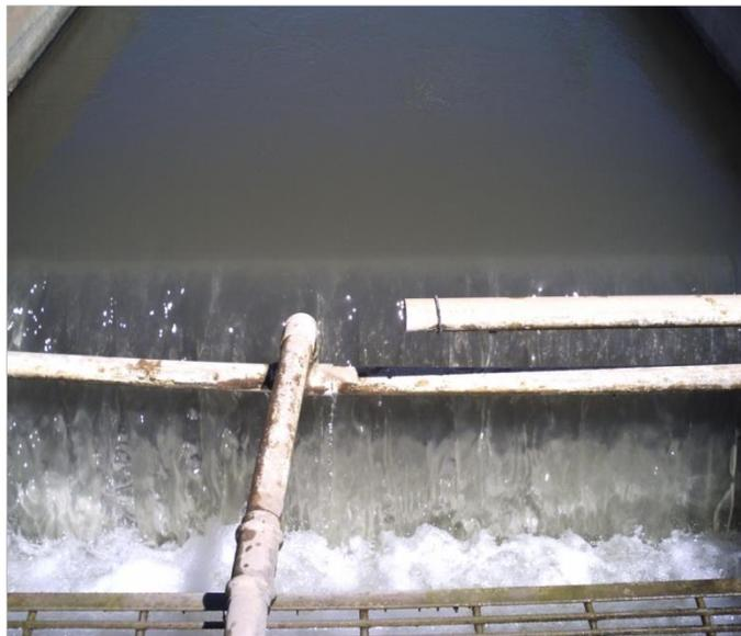
Figura 7. Fotografía del aforo para la suministración de reactivos para la coagulación/floculación
