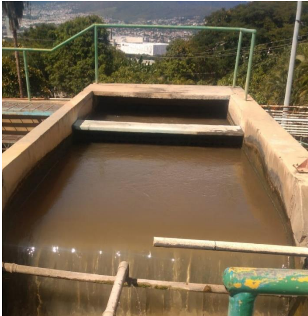
Ilustración 10 Canal de entrada del agua al proceso y dosificación del floculante.
