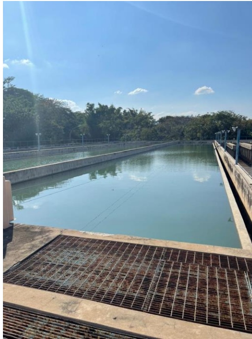
Ilustración 12 foto de sedimentadores
