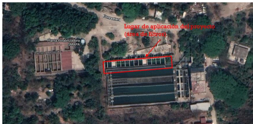
Figura 1 Vista aérea de la planta potabilizadora Los Pájaros de SMAPA
