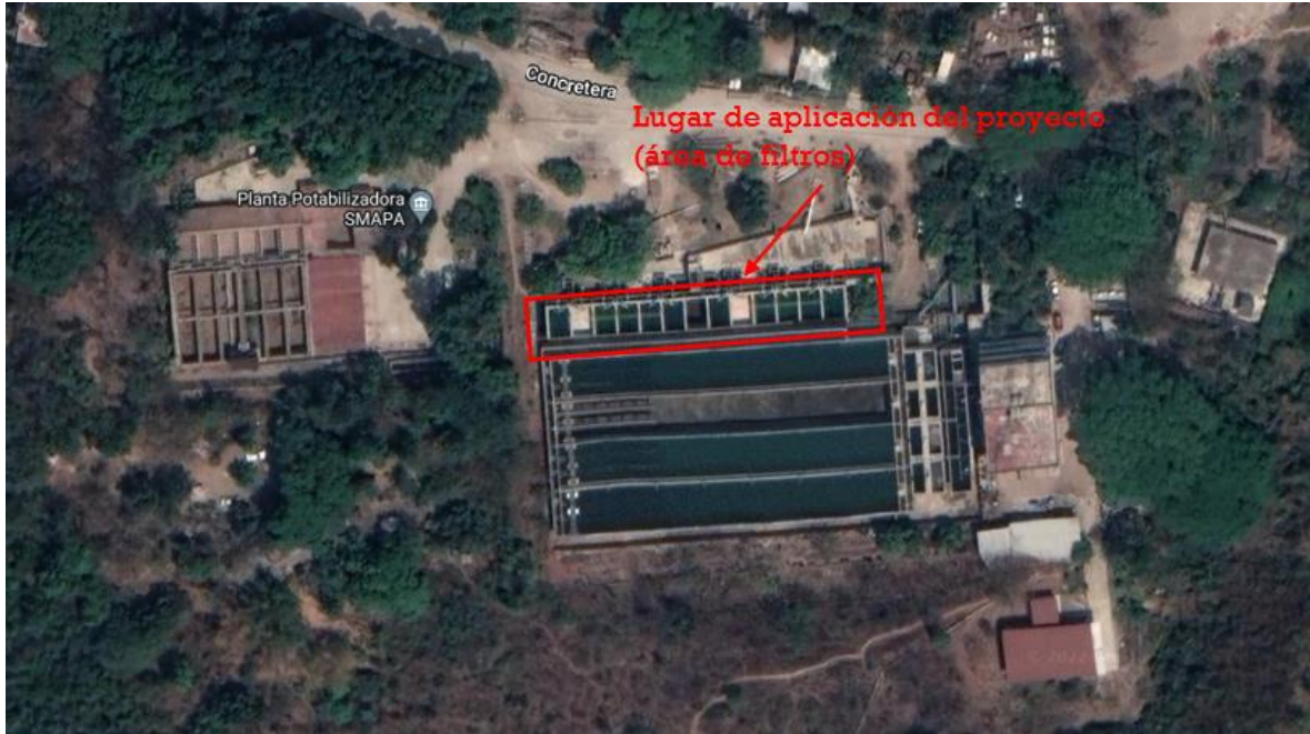
Ilustración 9 Foto aérea de la planta Los Pájaros
