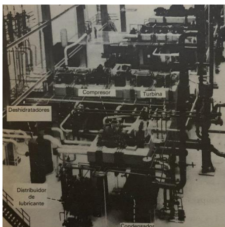
Ilustración 22. Disposición de compresor centrífugo con salida por debajo.
