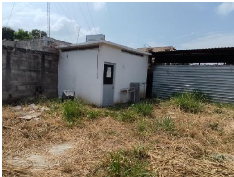
Figura 75. Vista externa del almacén temporal de residuos peligrosos
