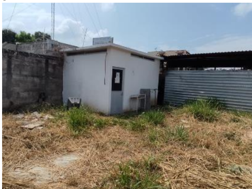
Figura 8. Vista externa del Almacén de residuos peligrosos.
