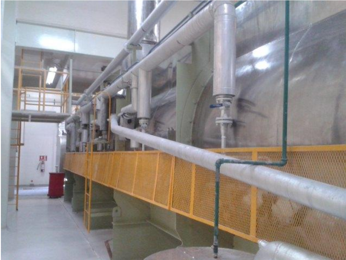
Figura 2.6 instalación de electroválvulas
