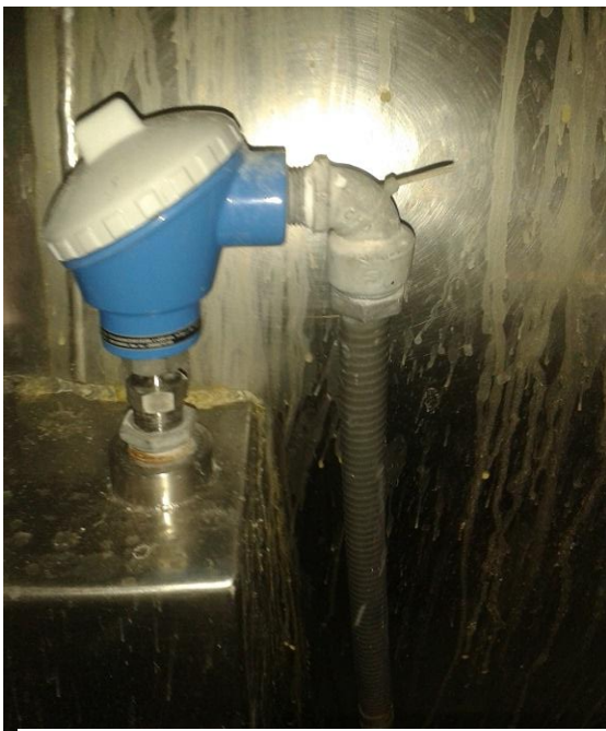
Figura 2.5a instalación de termopar
