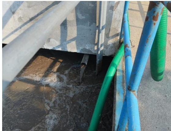
Figura 16. Purga de lodos del sedimentador secundario de la planta de 28 L/s. (Elaboración propia).
