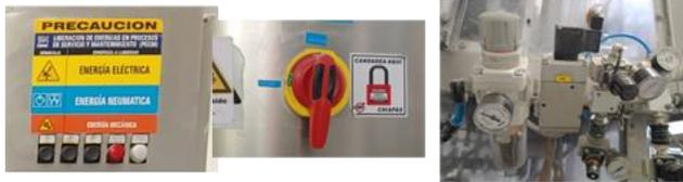
Se identifica la fuente de energía peligrosa , en este caso es energía eléctrica y energía neumática
