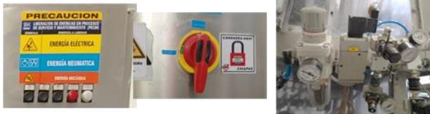
Se identifica la fuente de energía peligrosa, en este caso es energía eléctrica y energía neumática
