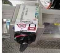
Se identifica la fuente de energía peligrosa en este caso solo seria la energía eléctrica, que se encuentran arriba del tablero com
