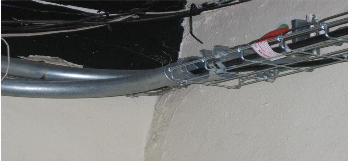
Figuras 3. 21 Ductos acorazados
