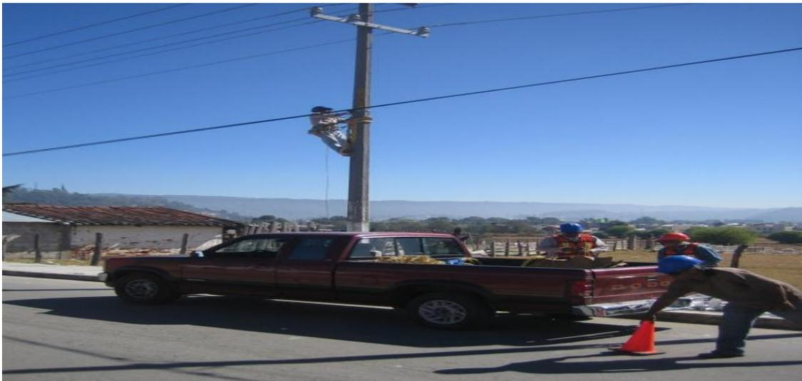
Figuras 3. 19 Tendido y tensionado de fibra óptica
