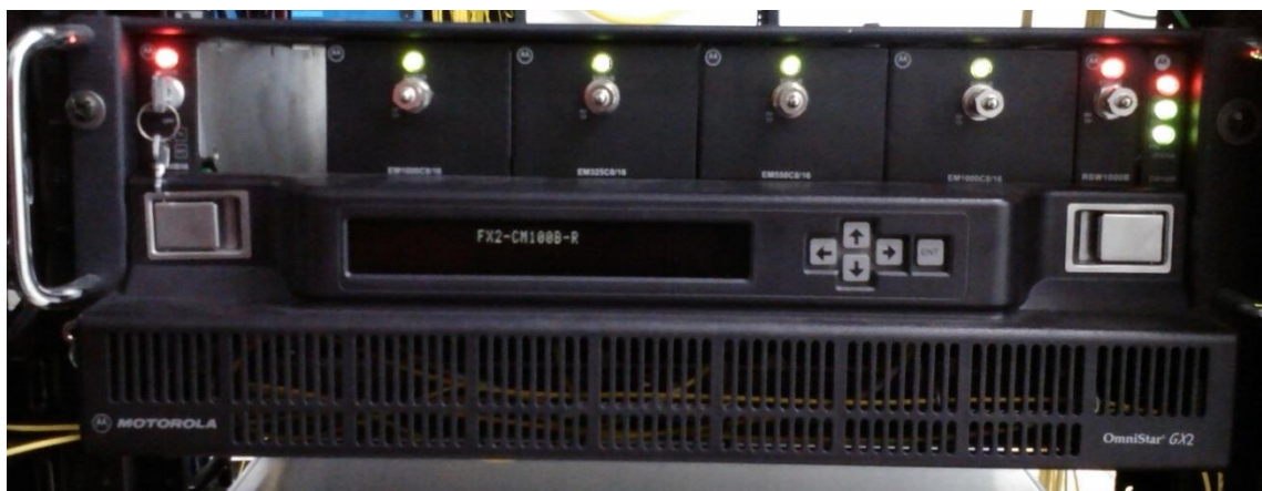
Fig. 3.10 – Receptores donde por medio de fibras ópticas llegan a él canales con una señal 50 % análoga y 50 % digital.
