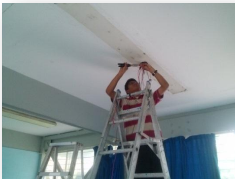
Fig. 3.1 Conexión de cables para el sistema de iluminación
