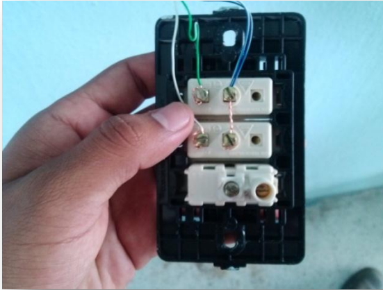
Fig. 3.3 Conexión del cable telefónico a los apagadores timbre
