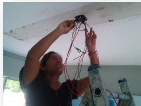
Fig. 3.1 Conexión de cables para el sistema de iluminación
