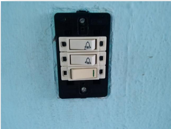
Fig. 3.4 Instalación completa de los apagadores timbre
