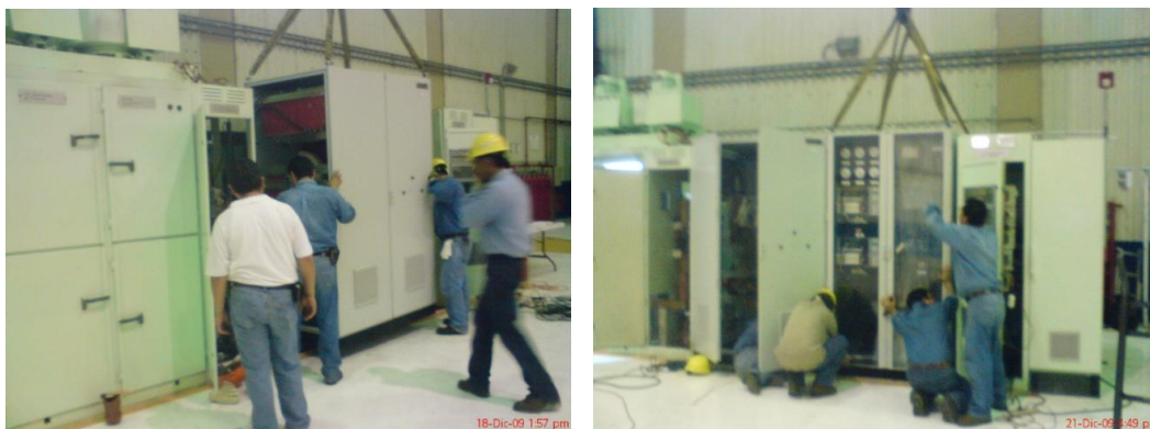
Fig. 6.14.3 Montaje del Gabinete EX01, EX02, EX03 Y EX04
