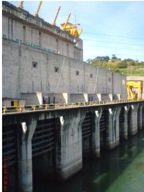
Fig. 4.4 Obra de desfogue C. H. Peñitas
