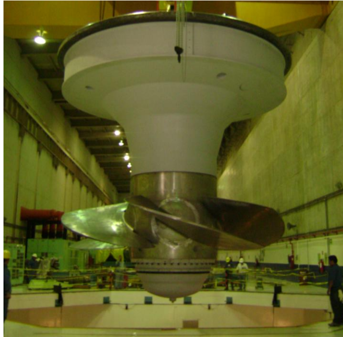
Fig. 4.7 Turbina Kaplan C. H. Peñitas
