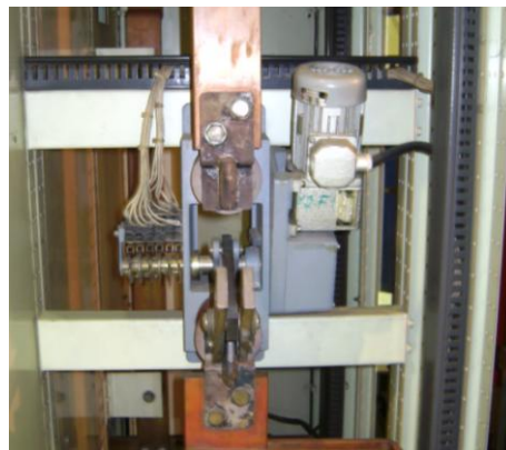
Fig. 6.11.2 Seccionador de excitación
