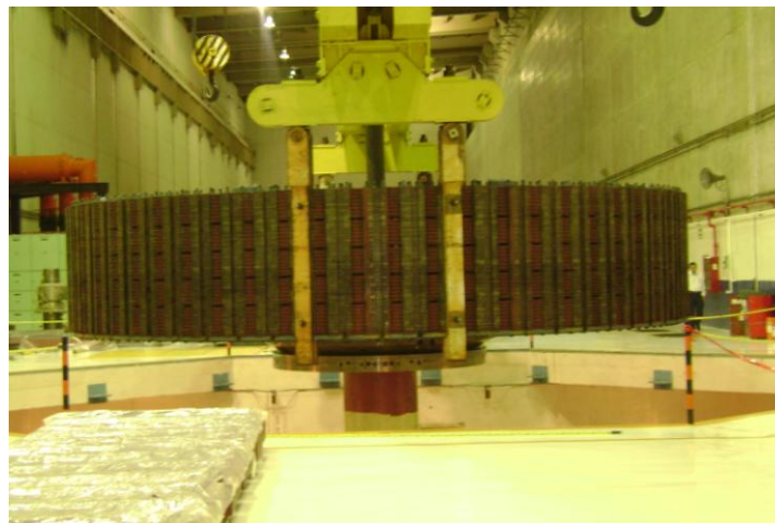
Fig. 4.8.1.2 Rotor C. H. Peñitas
