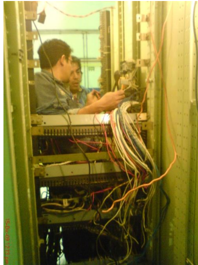
Fig. 6.13.1 Desmontaje del Gabinete YA.10
