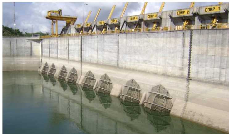
Fig. 4.3 Obra de Toma C. H. Peñitas
