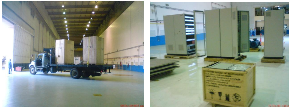
Fig. 6.14.2 Llegada a Casa de Maquinas
