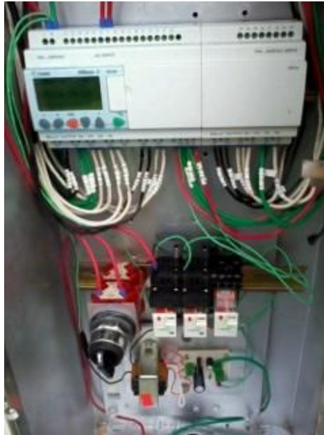
Figura 4.17 imagen real del juego de relevadores de la alarma
