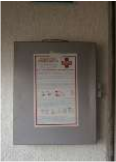
Botiquín sin señalamiento en el Departamento Civil.
