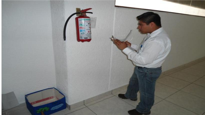
Figura 6.2. Inspección de extintores
